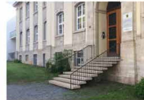
Der Eingang zur Azenbergstraße 14 mit der neuen Eingangstreppe
